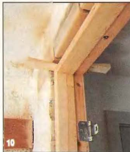
Подтесав выступающие кирпичи на кромках проема, вставляют в него дверную коробку и фиксируют деревянными клиньями. Если коробка — без порога, снизу между боковыми стойками временно прибивают распорку.
