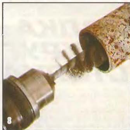
8 Чистка от ржавчины внутренних стенок трубы с помощью цилиндрической щетки-ершика.
