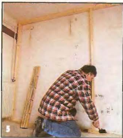
Прежде чем приступить к выдалбливанию проема в перегородке, монтируют потолочные подпорки в его зоне. Они значительно уменьшат вероятность разрушения старой кладки, остающейся над проемом.
