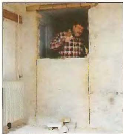
Когда раствор схватится (не раньше чем через сутки), делают вертикальные пропилы уже до пола с обеих сторон перегородки и выдалбливают проем между ними.
