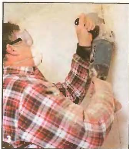
Используя угловую шлифовальную машинку («болгарку») с отрезным диском по камню, выполняют прорезы длиной 20-30 см по разметке вниз от обозначенного базового ряда.
