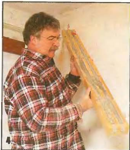
Чтобы изготовить несущую верхнюю перемычку над дверным проемом, в пазы, выбранные в кирпичах с помощью «болгарки», вклеивают на растворе толстые арматурные прутки. Швы между кирпичами перемычки тоже сразу заполняют раствором.
