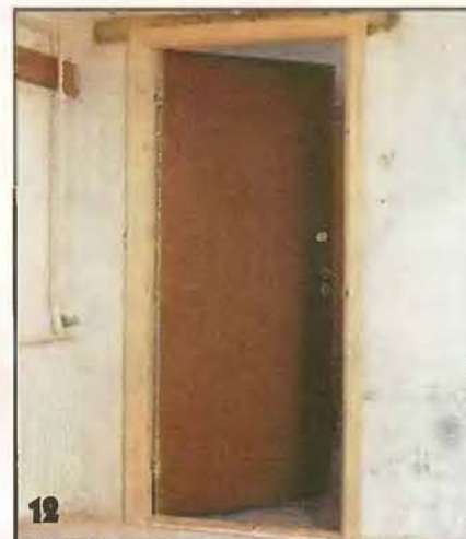
В завершение навешивают на петли дверное полотно и прибивают наличники. Стену с новым дверным проемом отделяют потом, как предусмотрено проектом.
